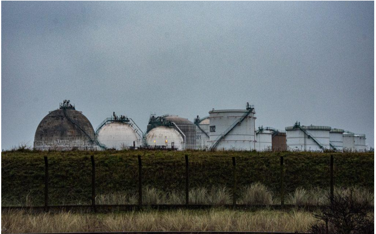
Les réservoirs de naphta et de GPL (gaz de pétrole liquéfié), à proximité immédiate du “vapocraqueur” de Versalis. Photo : Matthieu Slisse / Mediacités
