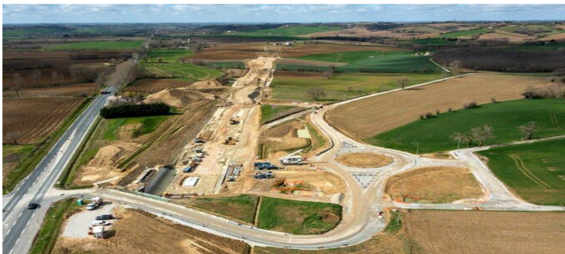
Des travaux le long du tracé de la future autoroute A69, près de Puylaurens. © Photo Fabien Ferrer / Atosca via AFP
